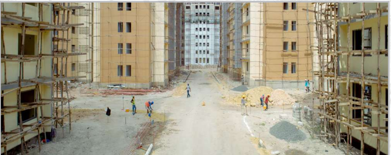
Hatua ya ujenzi wa mandhari ya nje (landscape) katika mradi wa ujenzi wa nyumba 644 za Magomeni Kota.
